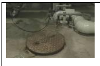
ヒートポンプによる冷水は地下へ。一部は冷房需要に対応。
