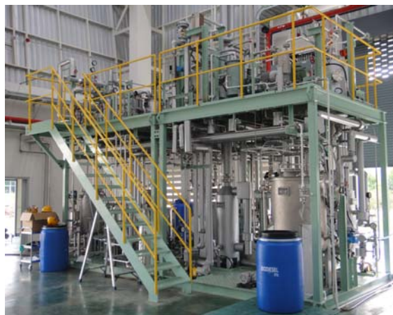
図1 タイ科学技術研究院に設置された高品質 BDF 製造パイロットプラント (1.0ton/日)
