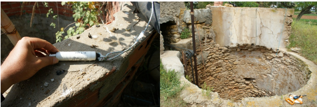
写真 5: 水位センサーロガーの設置の様子
