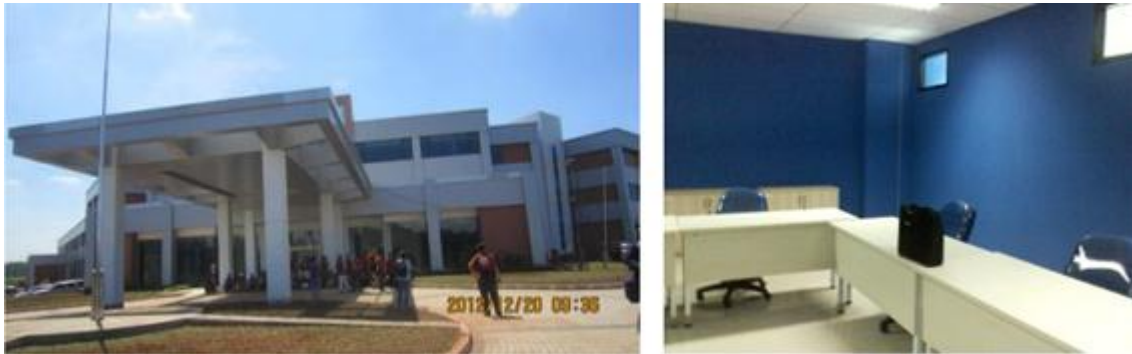
図 4 竣工した BPPT-GEOSTECH と MCCOE 使用区域の一室
