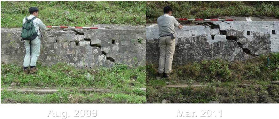
図 4-3-13 擁壁に表れた地すべりの継続的な変位 (クンガラプテン地区. 左 Aug. 2009; 右 Mar. 2011)。
