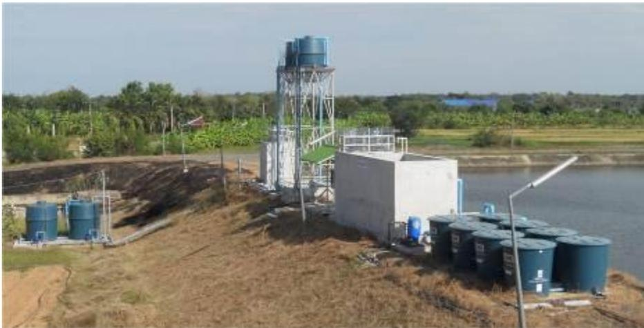
図 10 Buriram 県に建設された下水処理水の農業利用のための浄化プラント
