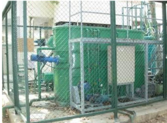
図2 チュラロンコン大学に設置されたパイロット IT/OD-MBR 一段嫌気性消化システム
