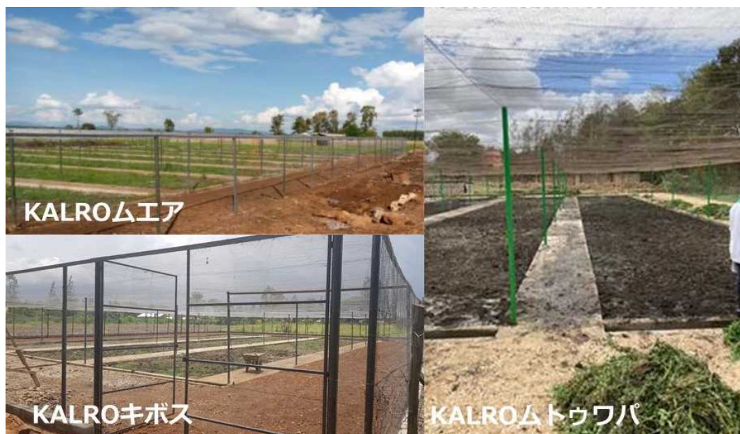
図2 KALRO ムエア、キボスおよびムトゥワパ支所に造成した試験水田
