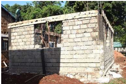
図 8 精米機等を設置するための施設建設の様子
