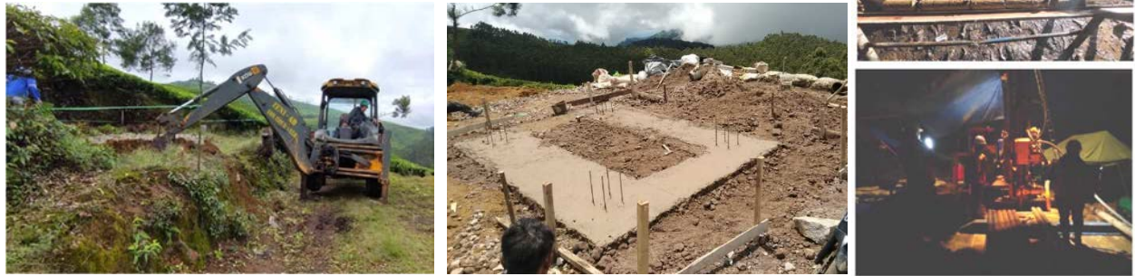
【TCH-A でのボーリング用地掘削 (左), 台座建設 (中), 夜間の掘削工事 (右) の写真】
