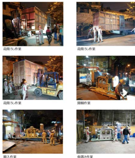
図3 ハノイ工科大学へのSDD装置の搬入作業
