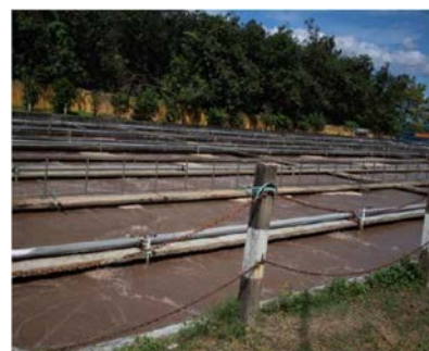
図 6 工業用廃水処理装置
