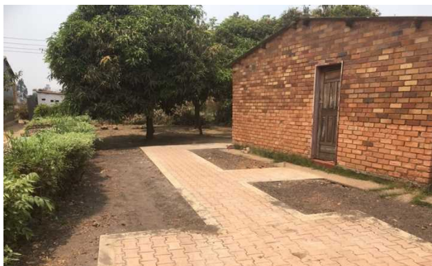
ZMERIPによる住宅地の環境修復。非汚染土壌による被覆や植栽を実施
