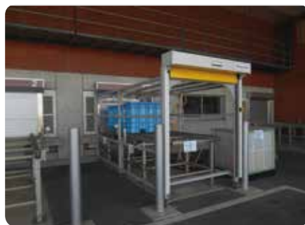
電解水散布ユニットの設置
