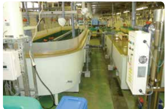
サケ用半閉鎖循環式陸上養殖設備
