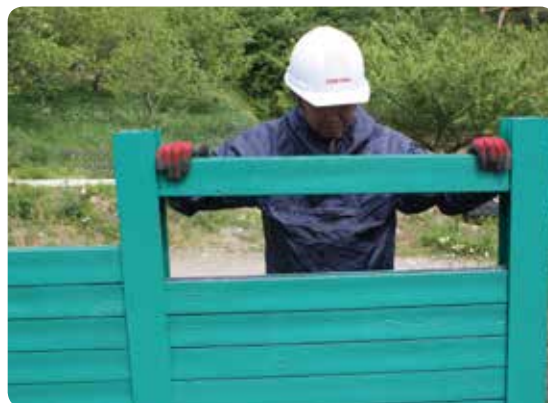
H鋼に遮蔽版を差込む
