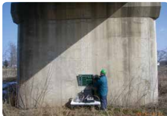
施工年度の異なる橋での透気係数測定
