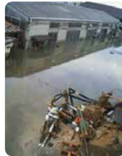
共和アルミニウム工業(株)の被災状況
