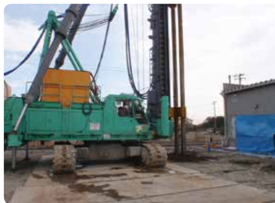
施工試験状況
