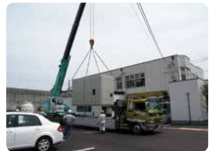
① 据え付け作業
