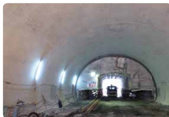
CfFAが使われた釜石山田道路のトンネルの壁面
