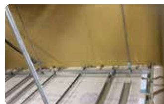
試験施工外観（つり天井に動的変位を与え、見切り板の変位追従性を検証済）
