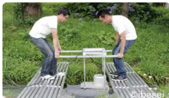
水力発電装置設置の様子
