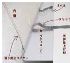
見切り板取付け（壁、天井構成）セーフティコーナードは軽量不燃マグネシウムをクリップで挟み込み、ZバーでX・Y・Zの3方向の揺れを吸収
