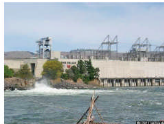
【発電所に隣接するGoogleの巨大データセンター】
