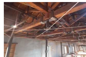
富岡倉庫 1 号倉庫
