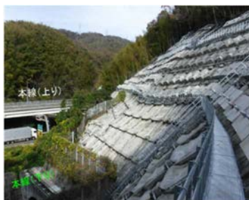
図 4.8-3 試験施工現場の外観
