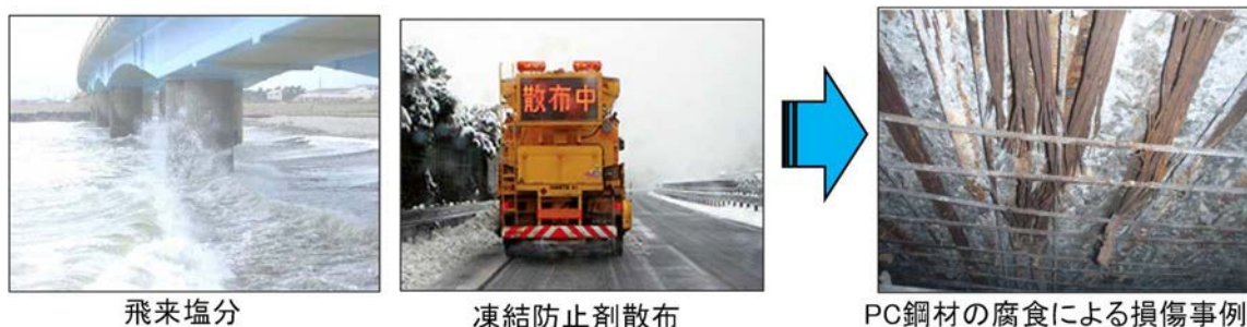
図 4-5-1 塩害による劣化事象の概要
