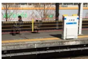
昇降式ホーム柵（JR 六甲道駅）
