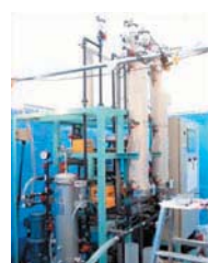
塔式排水処理装置
