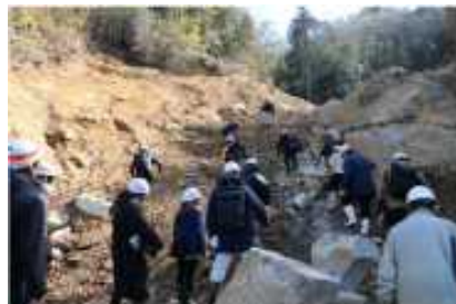
土石流センサー設置現場
