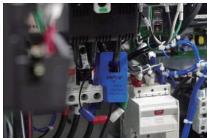
工作機器の分電盤に取り付けられた例。分電盤自体への加工は不要で、設置もクランプするだけである。
