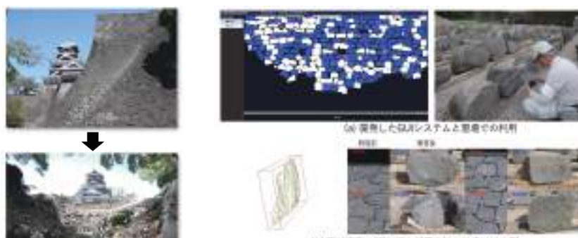
(a) 開発した石垣照合システムのGUIと現場での利用の様子 (b) 3D計測により復元した石材表面と本システムにより特定した崩落前後の石材の例
