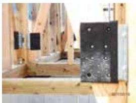
DIT制振筋かい金物
