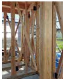
DIT制振筋かい金物の設置状況
