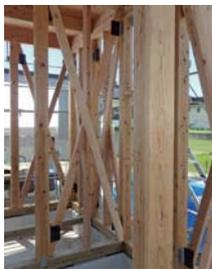
DIT制振筋かい金物の設置状況
