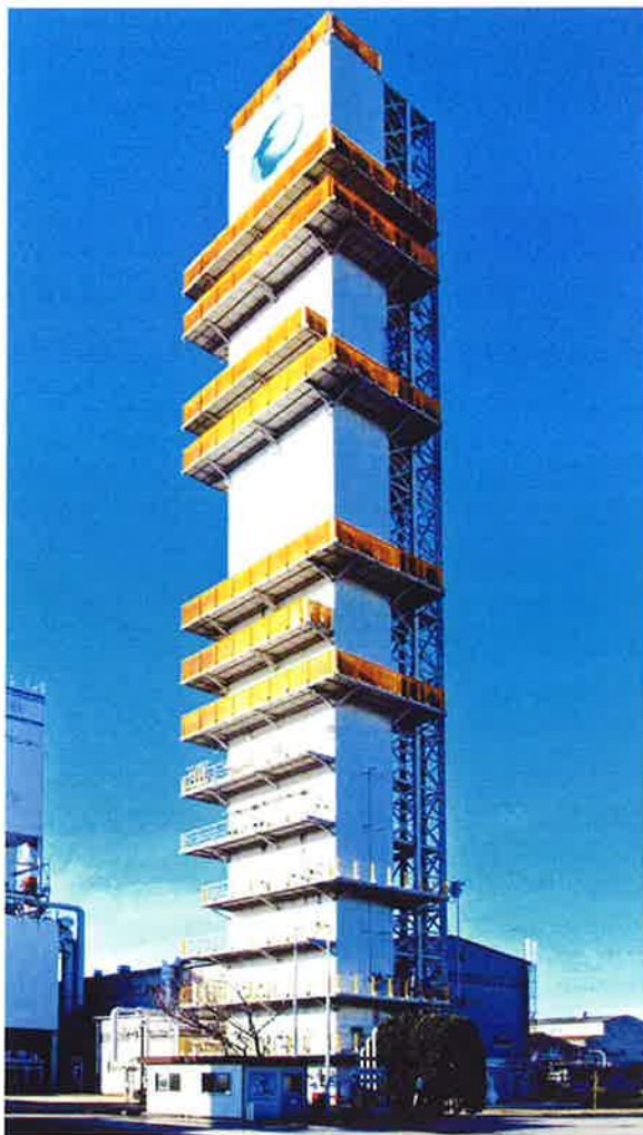
^{18}\text{O} 製造プラント 7m × 7m × 70m 99atom% 100 kg／年
