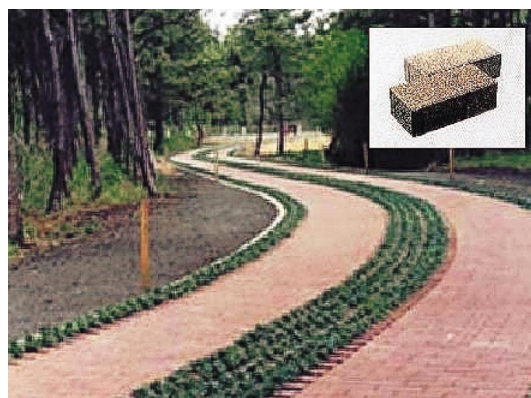
ヒートアイランド現象緩和を指向した コンクリートブロック
