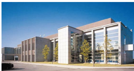
JST イノベーションプラザ石川
