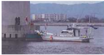
資材・機材は小型船舶で移送 作業時は安全監視船
