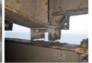
▲シェッド主梁端部破断
