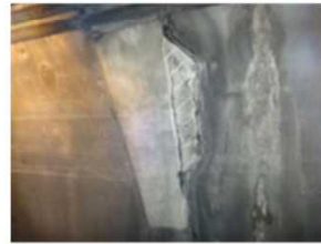
▲トンネル目地部
