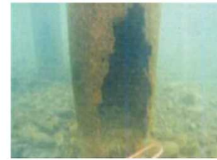
▲橋脚水中部の断面欠損
