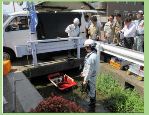
橋梁点検支援技術(狭小部)
