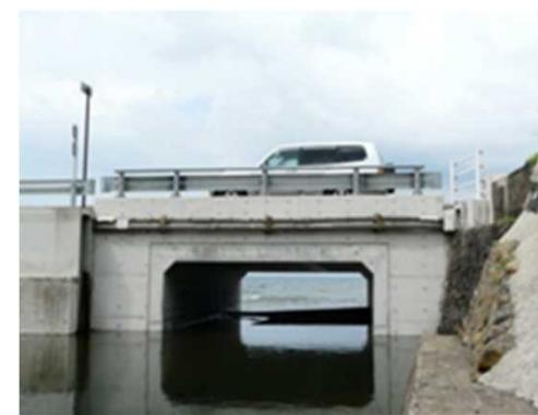
プレキャストボックスカルバートを既設橋の下面に設置した補強 14
