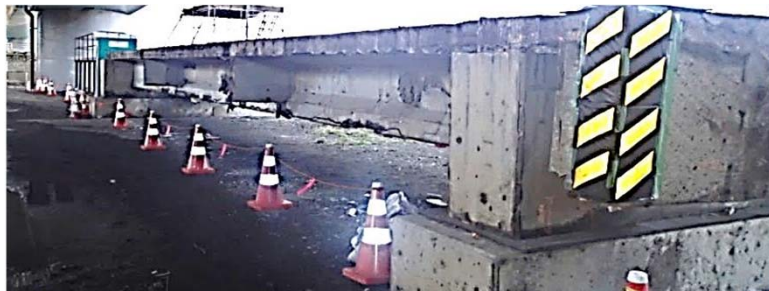
塩害劣化した撤去PCポストテンション桁
