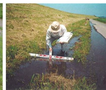
・河川堤防の滞水
