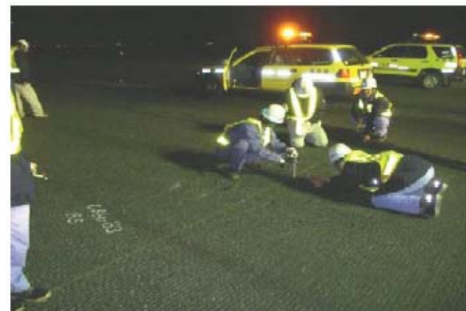
空港基本施設の点検
