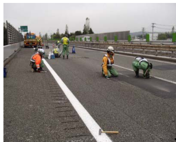
アスファルト舗装
