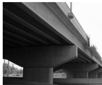
コンクリート構造物
