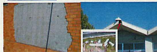
タイル健全性評価 校舎の外壁の崩落検査
