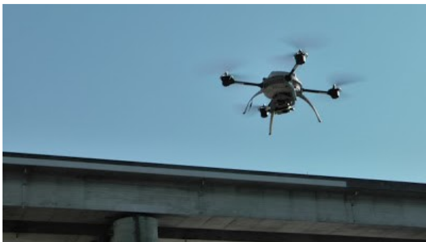
図4 飛行体(UAV)による点検
