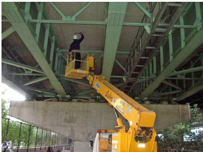
図2 橋下からのアプローチ
