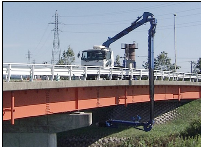
図3 橋梁点検車に乗った作業者による点検
