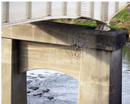
実橋梁での点検試行
