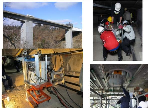
・ 供用中のPC箱桁におけるグラウト充填状況や鋼材の破断および腐食状態の可視化に成功（950keVX線現地実証計測）
