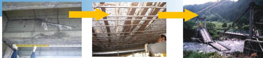
グラウト未充填の疑い      外観では判断できない内部鋼材の腐食      突然の落橋
