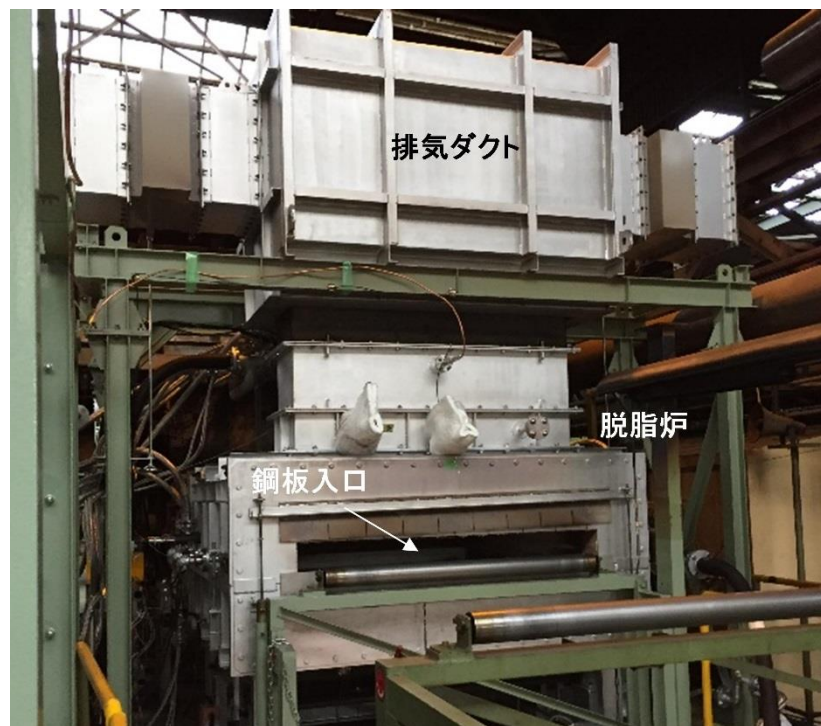
図 32 脱脂炉設置状況
