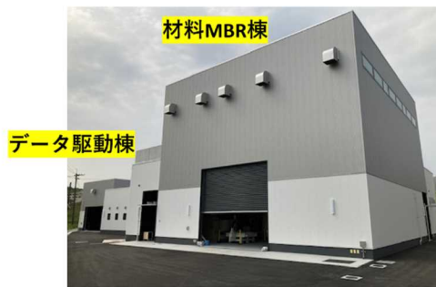
テストベッド棟の完成と大型設備整備の完了 (R4/3)
