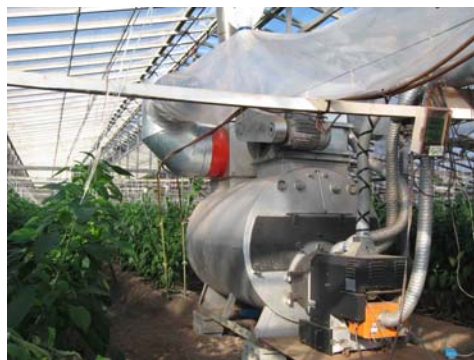
写真 3-3. 木質ペレット加温システム
