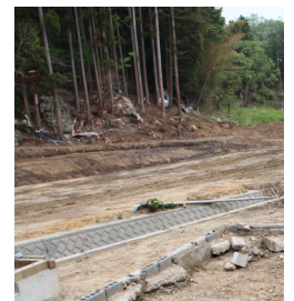
↑大谷鉾山のふもとから徒歩 5 分ほど下った「高漁村センター」(津波で破壊され残っているのは基礎のみ)でも土を採取。手前の穴は和式トイレの跡
