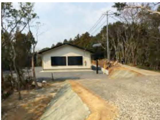
左：整備された避難路と国府防災倉庫（避難場所④）
