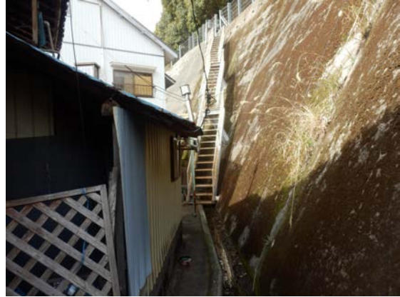
写真右 避難用階段の登り口の様子
