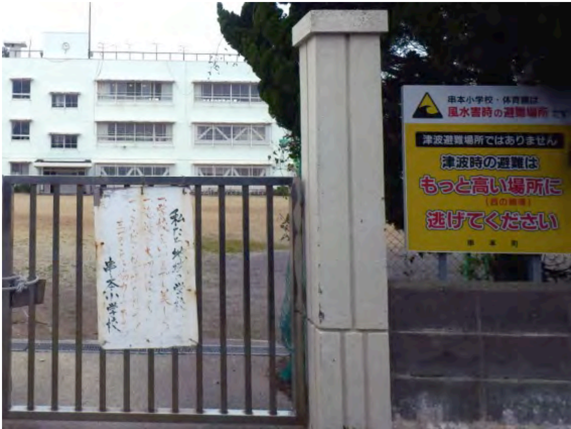
津波避難場所ではない旨を明示した串本小学校正門前の看板
