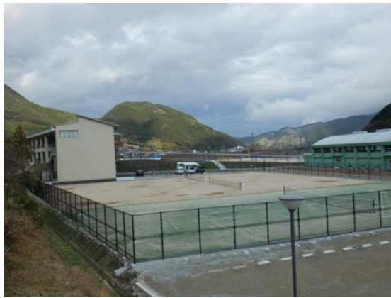
写真左 かさ上げされた輪内中学校
