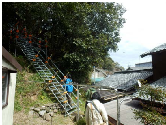
写真右 比較的新しい緊急避難用階段
