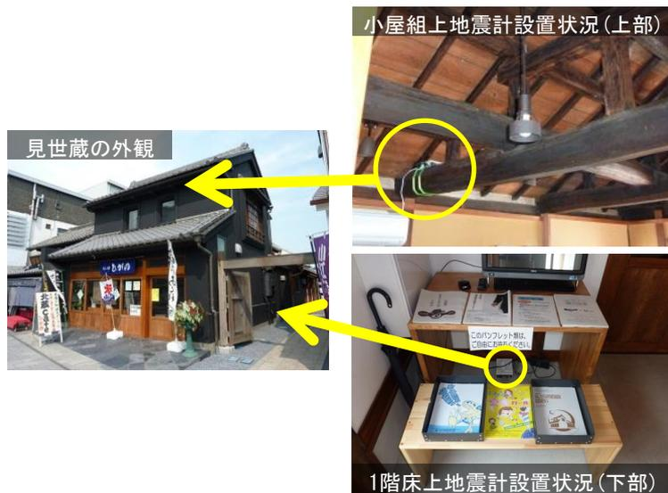
写真3 見世蔵の外観および地震計設置状況
