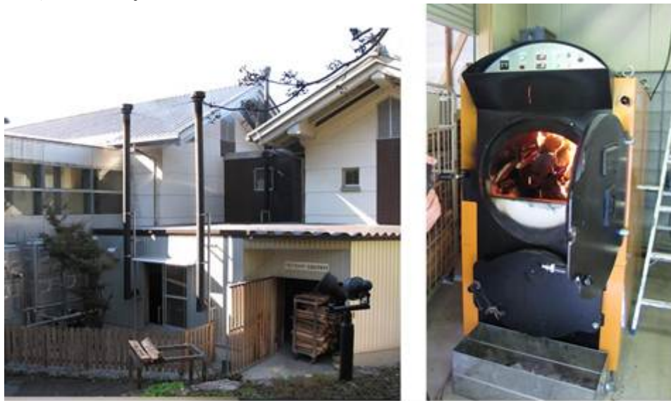
図 7 左：薪ボイラー建屋（いの町の温浴施設）右：薪ボイラー本体（須崎市の温浴施設）
