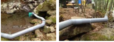
導水管 総延長 約70m 直径 0.2m
