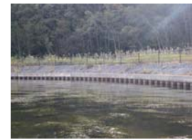
矢板コンクリート護岸
