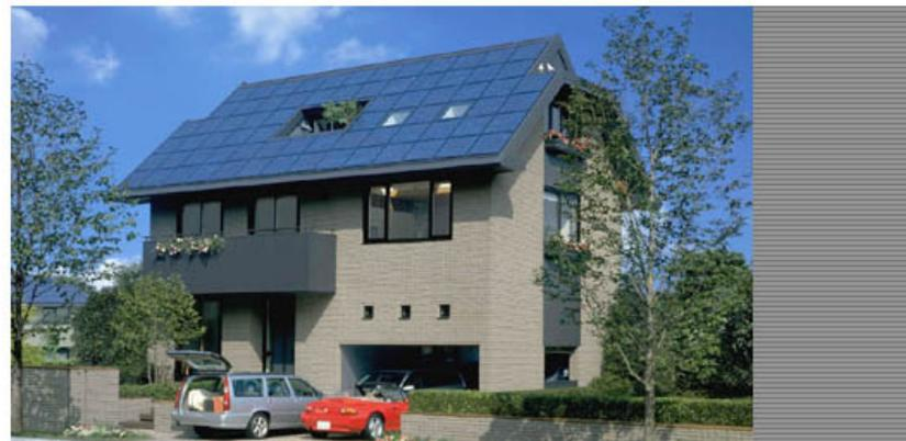
ミサワホームのハイブリッド住宅ならではの技術により、世界で初めてエネルギー自給率100%以上を可能にした住まいです。高断熱な外壁やサッシによる省エネルギー性、調理器具を含めたオール電化による設備類のエネルギー高効率化、そして先進の太陽光発電システムによる創エネルギー技術、すべてを融合させることで実現しました。よくあるような、太陽電池が付いているだけの家とは、ひと味違います。外観デザインひとつとっても、太陽電池がそのまま屋根材となる方式のため、街並みに美しく調和します。
