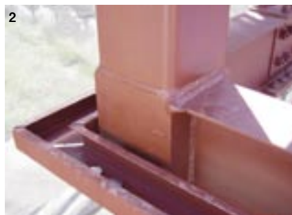
(1)高知市にあるグループホームくろしおの建設全景。複雑な柱梁接合部も容易に製作することができる。(3)愛媛県大洲法務局エレベータ設備工事の内部の様子で、全体がすっきりと仕上がっている。(2)「WAWO工法+一体化工法」による柱梁接合部。
