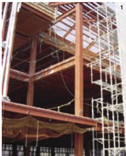
(1)高知市にあるグループホームくろしおの建設全景。複雑な柱梁接合部も容易に製作することができる。(3)愛媛県大洲法務局エレベータ設備工事の内部の様子で、全体がすっきりと仕上がっている。(2)「WAWO工法+一体化工法」による柱梁接合部。
