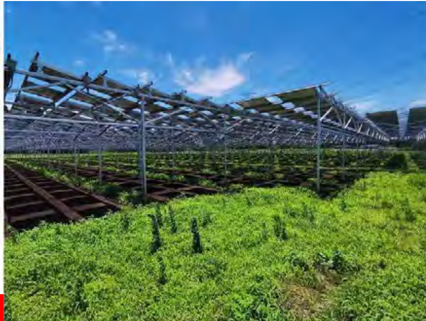
ソーラーシェアリングの撤退理由から見る、生き残る条件 (2020年7月21日) EnergyShift編集部
