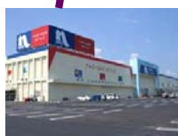
ホームセンター 1kW 燃料電池 1台
