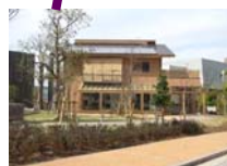
エコハウス 1kW 燃料電池 1台
