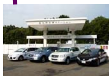
北九州水素ステーション 3kW 燃料電池 1台
