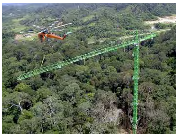
図 26 建設最終段階の林冠クレーン（2001.3）
