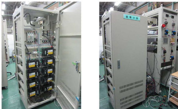
写真：蓄電装置
