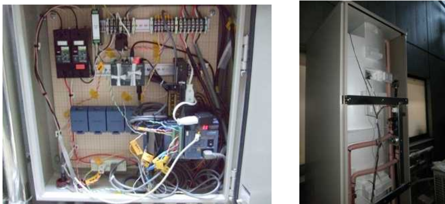
図 A-1. 実験利用した HPWH と計測系 (左: 電源部と各データ収集用のロガー 右: 温度計測用のセンサーをとりつけた貯湯タンク)
